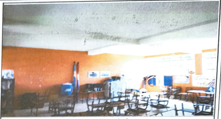
Foto 2: pintura paredes y terraza primer nivel
