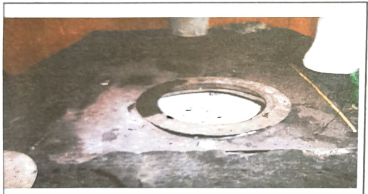
Foto 3: reemplazo de planchas para cocinar
