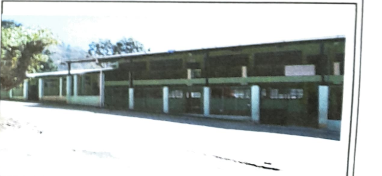
Foto 6: parte frontal del edificio escolar
